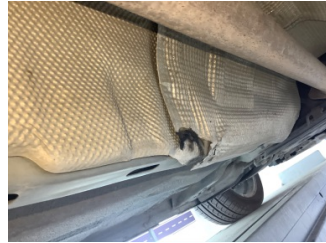
Egzoz sistemi, Susturucu muhafaza sacı orta > Hasarlı
