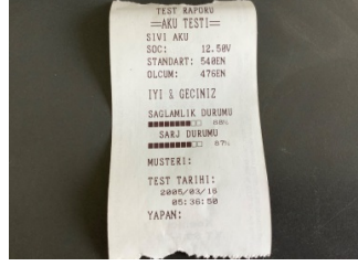
Elektrik donanımı/Pano, Akü > Test Sonucu
